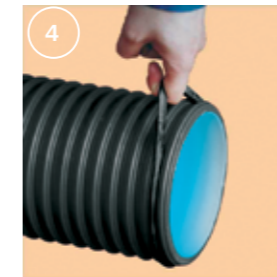
Sademevee torudel paigalda tihend viimasesse soonde
