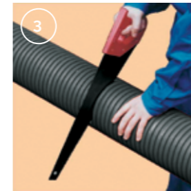
Plasttorusid lõigatakse peenehambulise saega
